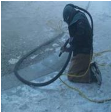
تصویر شماره ۵۱: عملیات سندبلاستینگ
