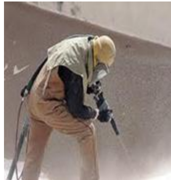
تصویر شماره ۵۱: عملیات سندبلاستینگ
